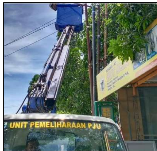
Gambar 3.2 Perbaikan Lampu Penerangan Jalan Umum oleh Tim PJU
