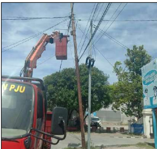
Gambar 3.2 Perbaikan Lampu Penerangan Jalan Umum oleh Tim PJU
