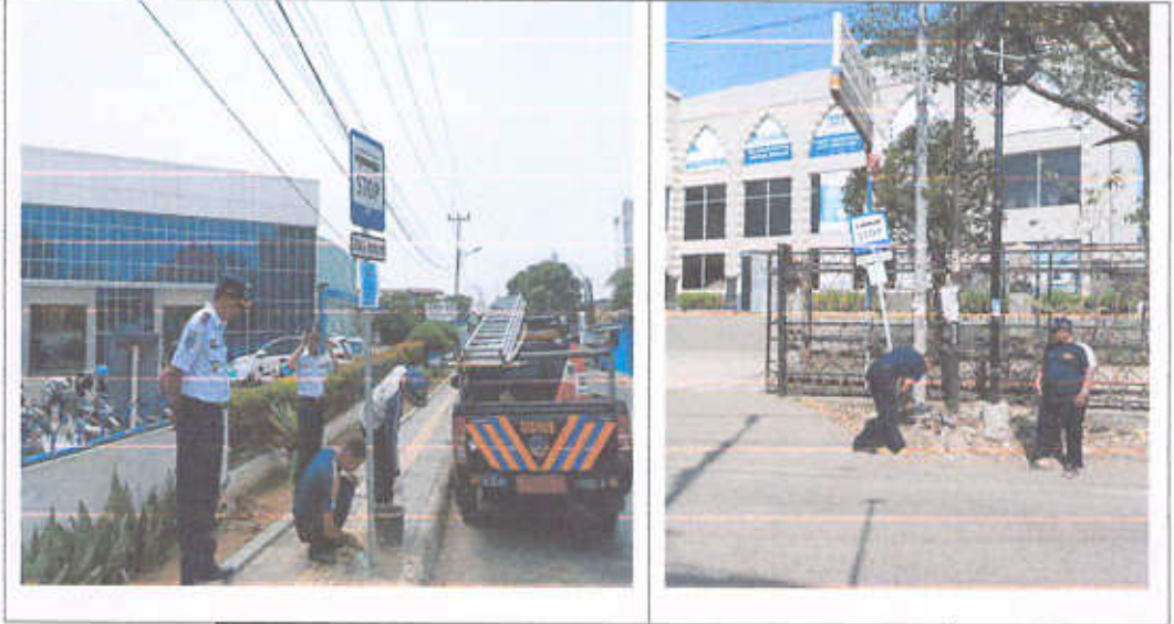
Gambar 3.12 Pemasangan Rambu Bus Stop
