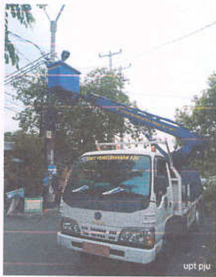
Gambar 3.2 Perbaikan Lampu Penerangan Jalan Umum oleh Tim PJU
