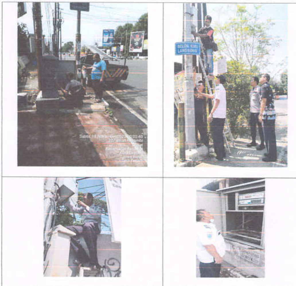
Gambar 3.5 Pemeliharaan Rambu dan Perbaikan Lampu APILL
