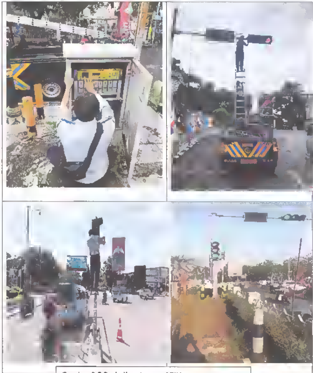
Gambar 3.5 Perbaikan Lampu APILL
