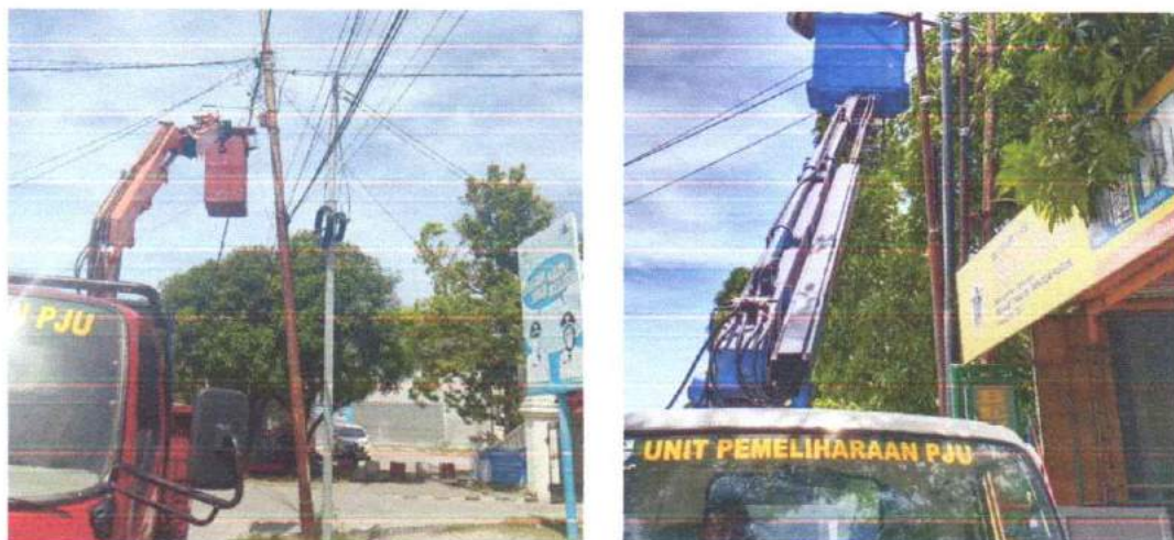
Gambar 3.2 Perbaikan Lampu Penerangan Jalan Umum oleh Tim PJU
