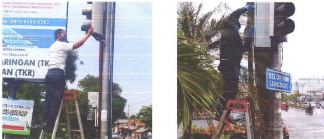
Gambar 3.6 Perbaikan Lampu Insyarat Lalu Lintas Oleh Tim yang bertugas
